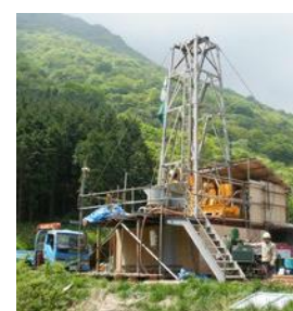
「地質調査ボーリング」
